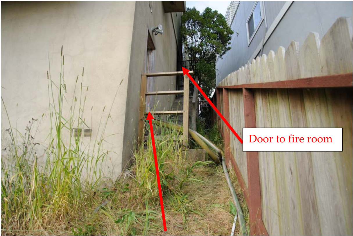
Sublevel 2 access door
